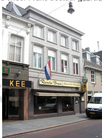
Afbeelding 245. De locatie, Orthenstraat 53, waar de voormalige pijpenfabriek van Eras gevestigd was (foto zomer 2008).
