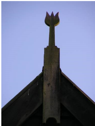
Afbeelding 6. Uilebord in de vorm van een tabaksplant zoals aanwezig op een tabaksschuur in Amerongen.
